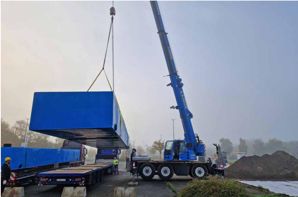
Schnelle Montage: Kurz nach Sonnenaufgang wurden die drei KS-Bluebox®-Elemente in Rostock angeliefert und im Laufe desselben Tages eingebaut.
