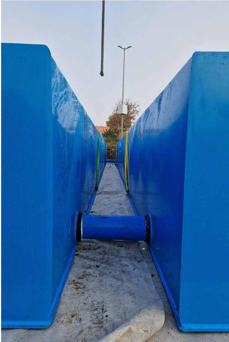
Die maximale Größe der einzelnen KS-Bluebox®-Elemente richtet sich nach der Ladekapazität des Transportfahrzeugs. Um die gewünschte Löschwassermenge zu erreichen, können die Boxen allerdings wie hier im Bild mit einem HS®-Rohr verbunden werden.
